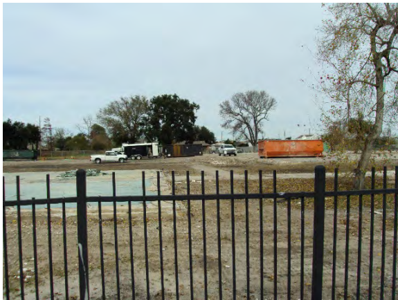
Osborne ES Demolition
