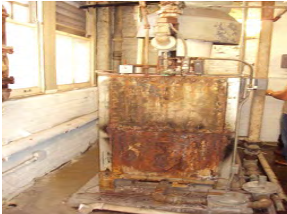
Agnes Bauduit Existing Boiler
